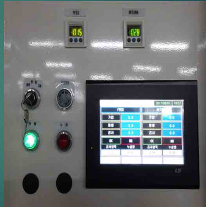
LEAK TEST: 전수 공압 검사
